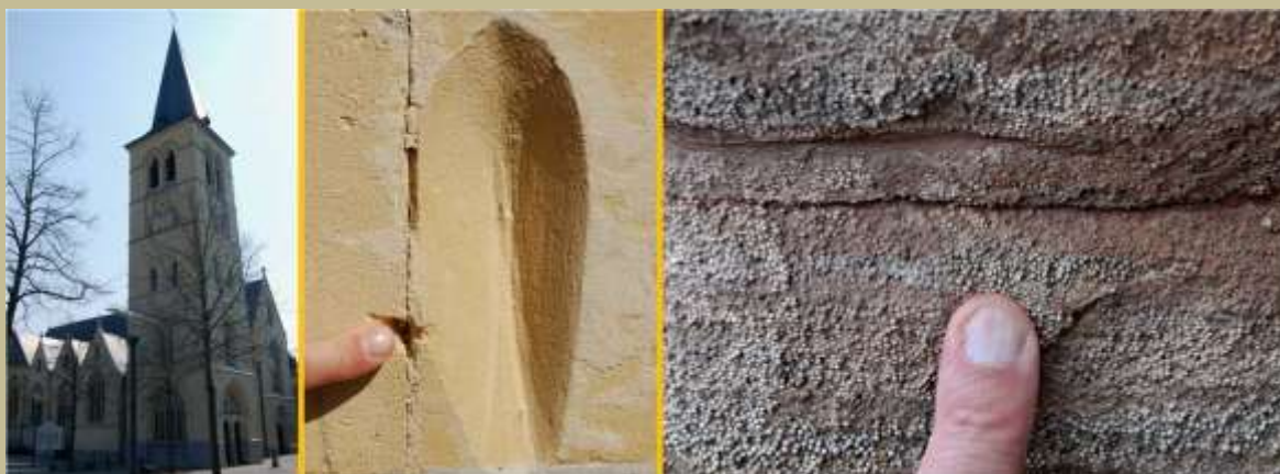
Krabsporen in kalksteen ('mergel') in Bree in België (foto 1+2) en in Rogenstein in Braunschweig in Duitsland (foto 3)
