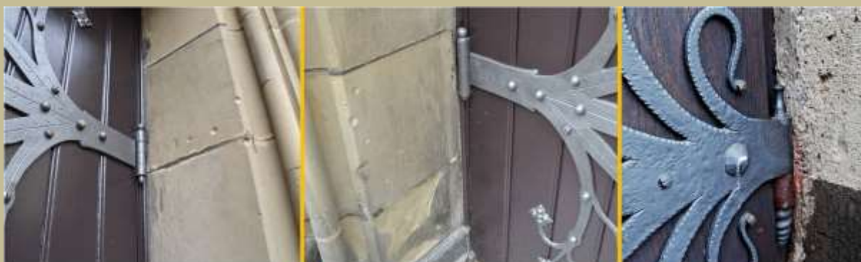
Een op krabsporen lijkend verschijnsel: pseudonapjes die zijn ontstaan door de ronde koppen van bouten waarmee de scharnieren van deuren zijn bevestigd.
