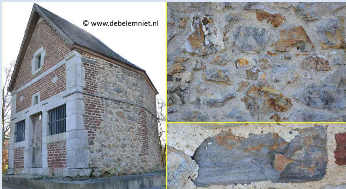
Afbeelding 23. Het Heiligenhuisje ofwel Sint-Annakapel. Aan de voorkant zien we gezaagde blokken donkere kalksteen (links). Aan de zijkant valt vooral de grote hoeveelheid vuursteen op (rechtsboven). Rechtsonder zien we een stuk zandsteen.
