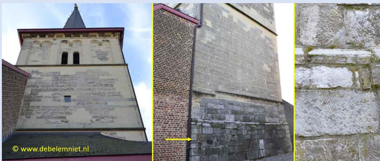
Afbeelding 10. Het onderste deel van de toren van de Sint-Lambertuskerk in 's-Gravenvoeren bestaat uit gezaagde blokken donkere kalksteen (gele pijl). Daar boven vinden we gezaagde blokken van geelwitte kalksteen.
