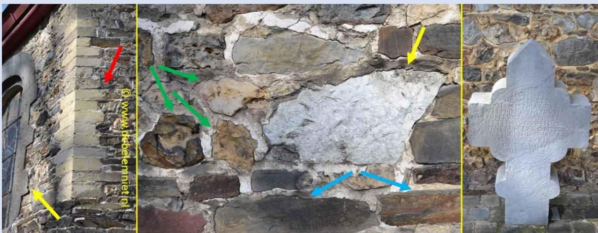
Afbeelding 19. De Sint-Pieters-Stoelkerk: vanaf de ingang zien we zowel links als rechts bij het koor een kettingverband van geelwitte kalksteen ('mergel', rode pijl). De raamomlijstingen bestaan uit donkere kalksteen (gele pijl). Op de middelste foto zien
