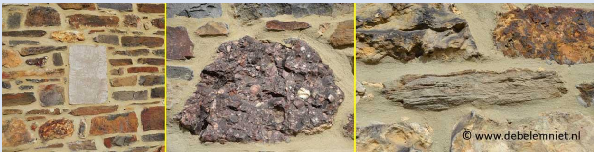
Afbeelding 17. Gezaagde donkere kalksteen (grijs blok in de linker foto), conglomeraat van Burnot (foto midden) en zandsteen (in het midden van de rechter foto) in de zijbeuk van de Sint-Martinuskerk van Sint-Martensvoeren.
