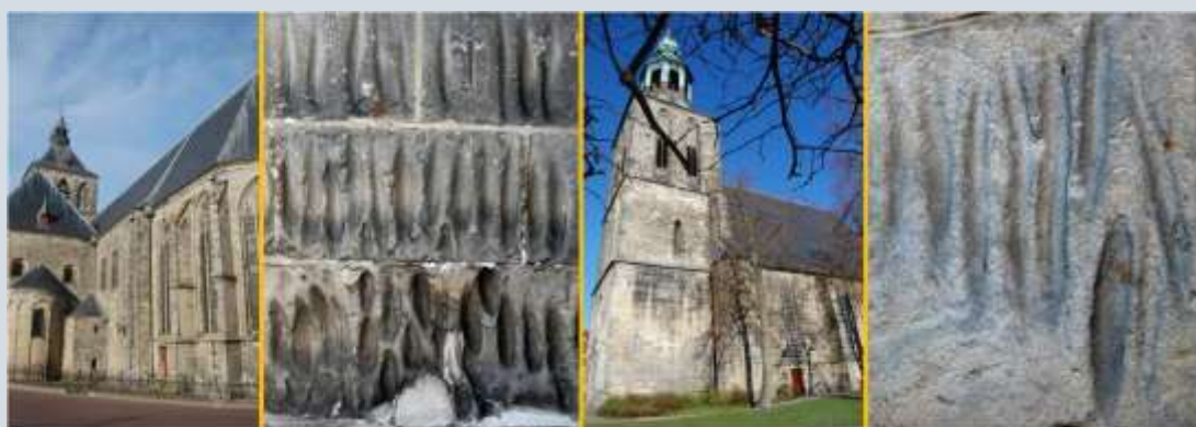
Schabespuren im Bentheimer Sandstein in Oldenzaal (Niederlande, Foto 1+2) und in Nordhorn (Deutschland, Foto 3+4)
